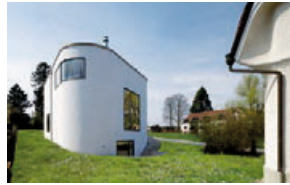
Dorenbach AG Architekten, Basel
